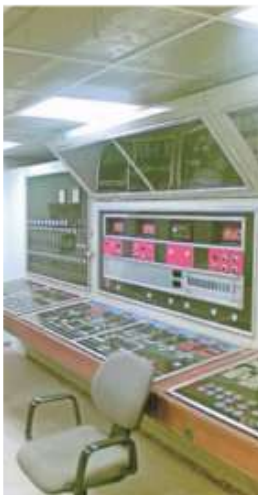
Erinnert an „Raumpatrouille Orion“, ist aber der frühere Regierungsbunker in Ahrweiler.
