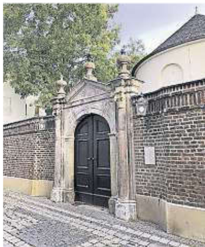
Wieder intakt: die Gartentoranlage der Mennonitenkirche
