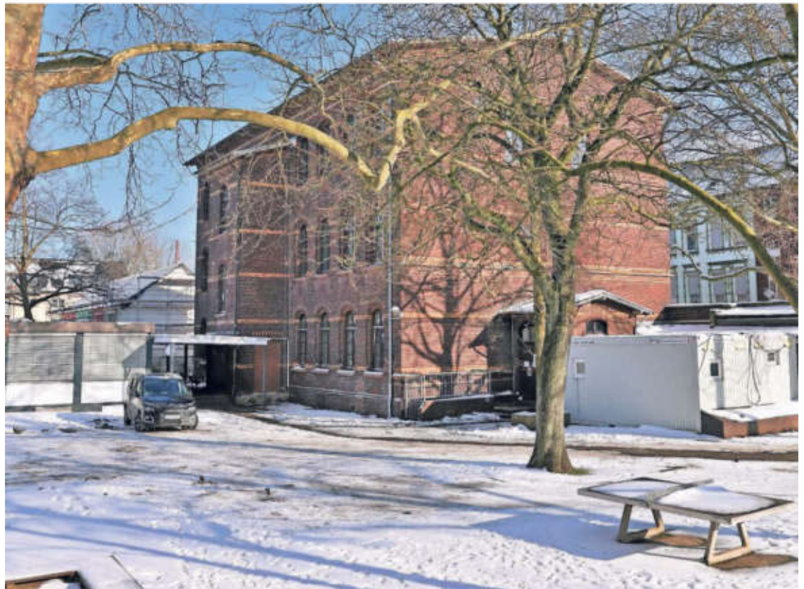
Im bitterkalten Februar dieses Jahres war in der Notunterkunft an der Feldstraße in einem Anbau die Heizung ausgefallen.
