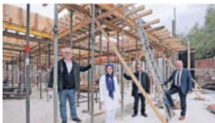
Der Hochbau der Moschee an der Gladbacher Straße hat Anfang des Jahres begonnen (v.l.): Architekt Nihat Bilgic, Halide Özkurt (stellvertretende Vorsitzende), Veyssel Arsoy (Projektbeauftragter) und Vorsitzender Ibrahim Öztürk.
