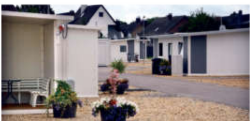
Das Flüchtlingsdorf an der Molkestraße in Willich soll nun doch noch nicht zurückgebaut werden. Archivfoto: Kähler
